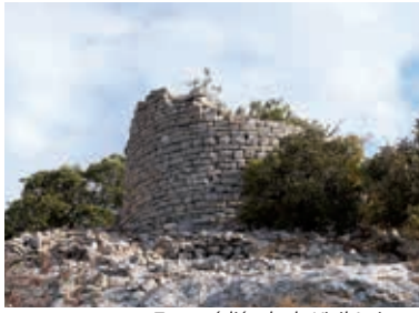
Tour médiévale du Vieil Artigues
